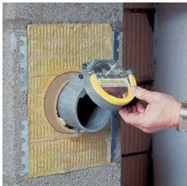
Abbildung 9: Einbaubeispiel Explosionsklappe (Quelle: http://www.schiedel.at/fileadmin/data/austria/SIH/SIH_Anwendungsblatt/SIH_Explosionsklappe.pdf )
