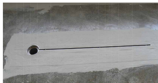
Skizze Schlitzrinneneindichtung
